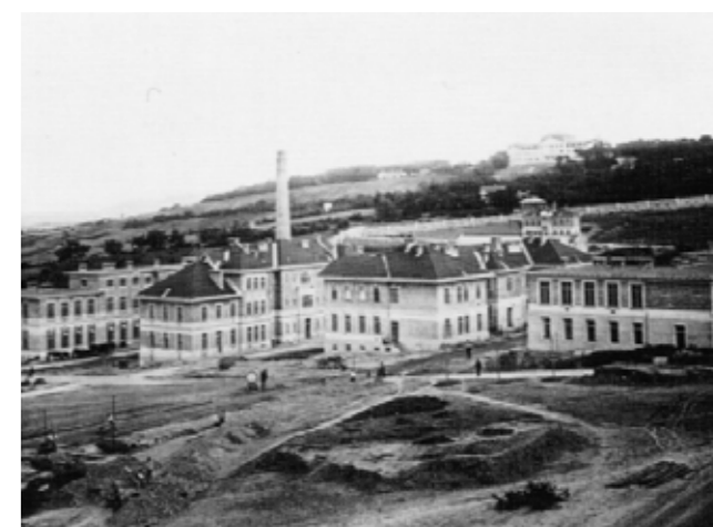
Abb.33 Beschäftigungshaus, dahinter die Wäscherei mit ihrem Rauchfang
