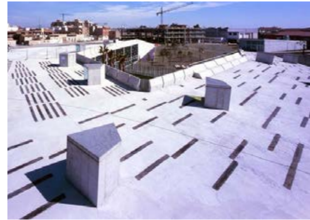
Abb.117 Begehbare Dach der Bibliothek
