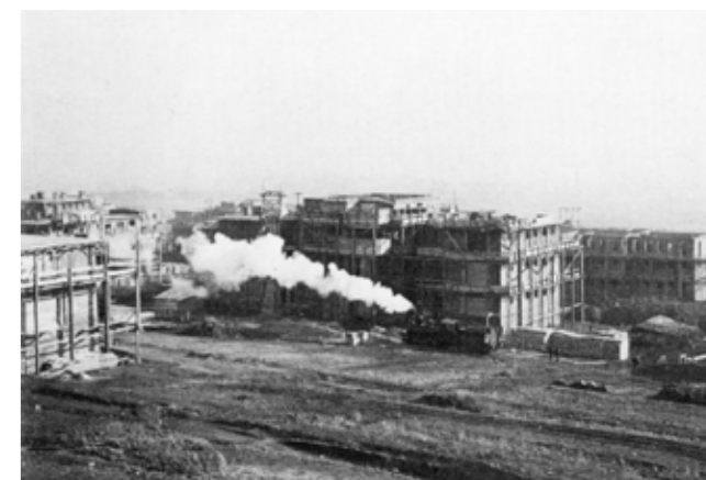
Abb.34 Die Baustelle am Steinhof
