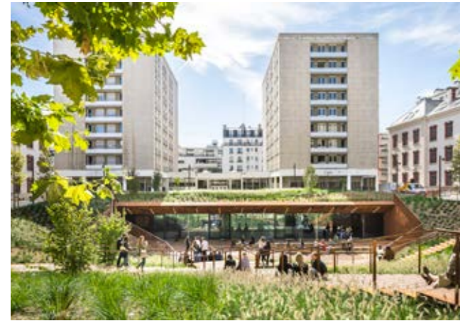
Abb.115 Erschließung des unterirdischen Entrees
