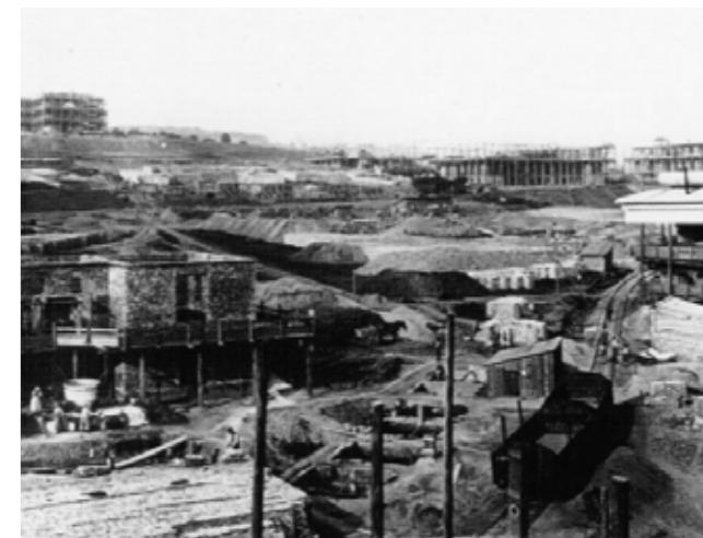
Abb.32 Der Bau der Pavillons
